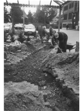
Arbeiten am neuen Schulhof
