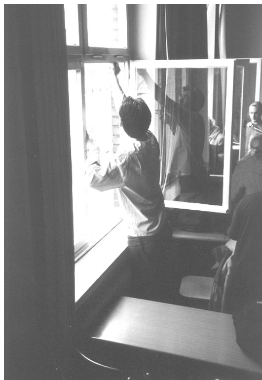
Schüler beim Abdichten der Fensterrahmen
